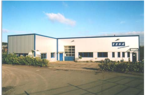
Durch Erweiterung des VESA-Firmengebäudes konnte die Fertigungsfläche verdoppelt werden.
